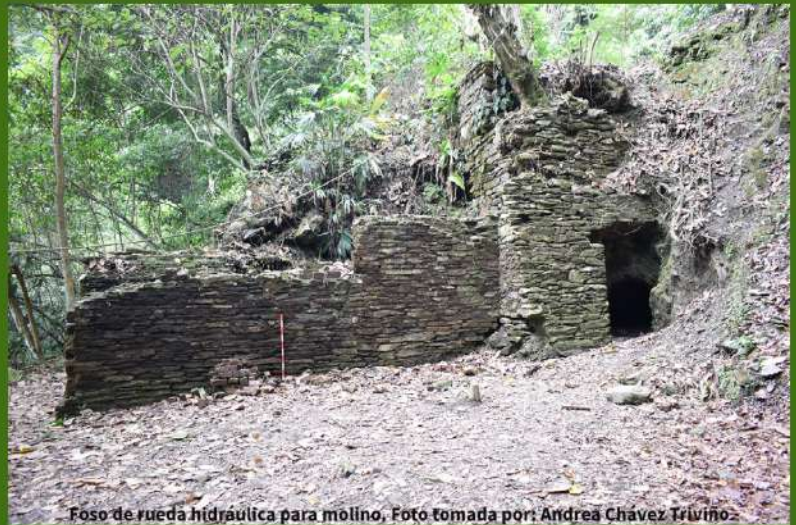
Foso de rueda hidráulica para molino, Foto tomada por: Andrea Chávez Triviño.
